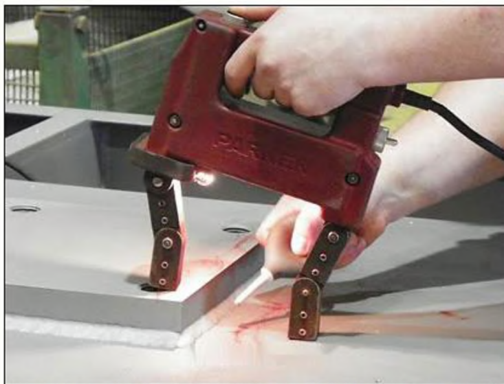
Проверка качества сварных швов магнитной дефектоскопией
