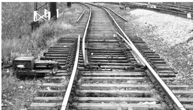
Рис. 12. Сбрасывающая стрелка
